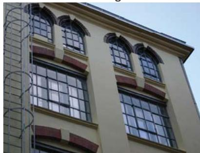
Die ehemaligen Ladeluken auf der Westfassade sowie der Seilzug im 4.OG bleiben erhalten und wurden innenseitig mit einer Brüstung gesichert. Die Elektrounterverdrahtung und die Ausgestaltung der Räume erfolgt durch die Gängeviertel-Genossenschaft.
