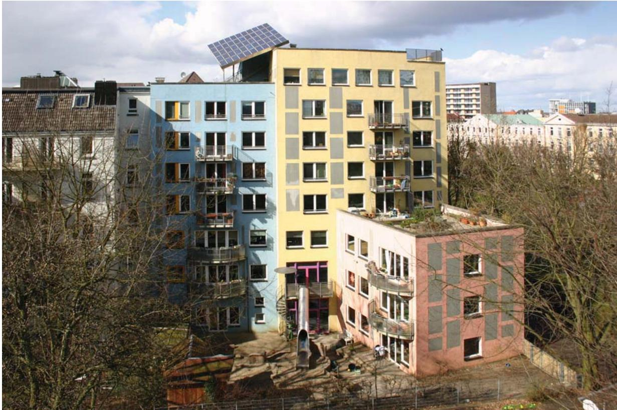
Südansicht mit transparenter Wärmedämmung und Fotovoltaiksegel
