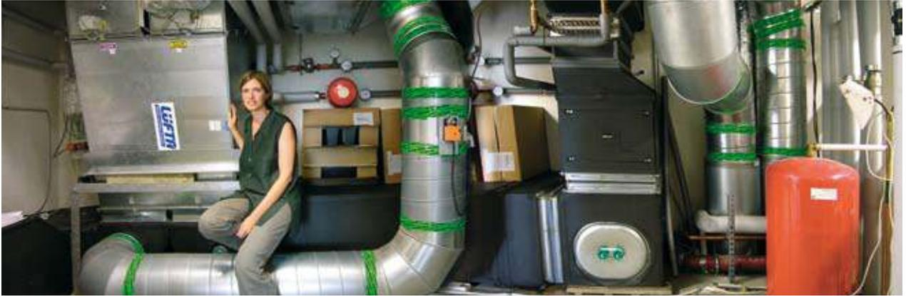
Die Lüftungsanlage mit Wärmerückgewinnung (ganz links) sorgt automatisch und kontinuierlich für frische Luft
