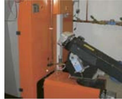
Brenner mit automatischer Pelletzuführung
